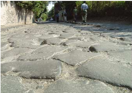
2300年もの使用に耐えるアッピア街道の敷石舗装
